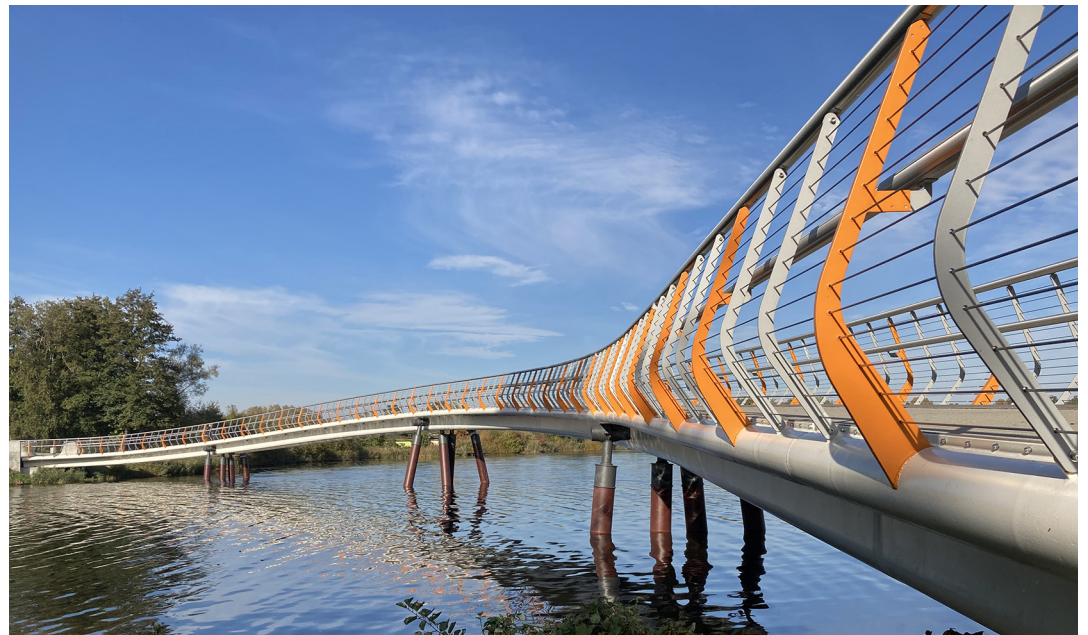
Mit dem Landesbaupreis 2022 in der Kategorie Konstruktiver Ingenieurbau ausgezeichnet: Die Radbrücke zwischen den beiden Halbinseln Dwang und Krösnitz. © SDS/Axel Klabe
