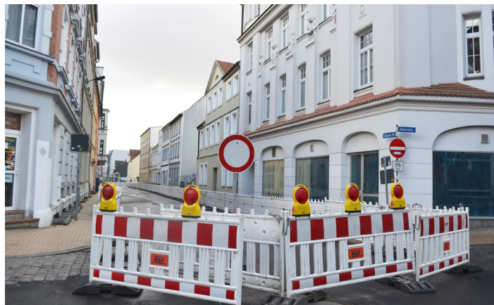
Wird fortgesetzt: Die Sanierung der Lübecker Straße zwischen Steinstraße und Platz der Freiheit. © Landeshauptstadt Schwerin
