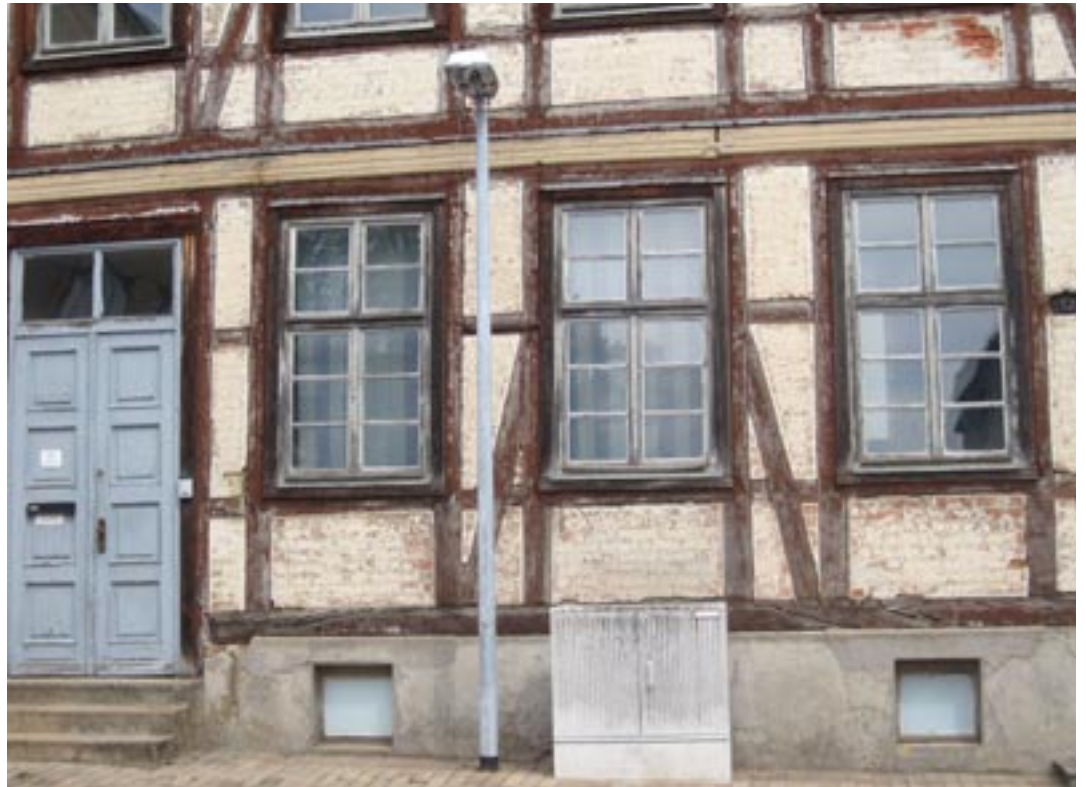
Seit einigen Tagen besser ausgeleuchtet: Der Große Moor mit zusätzlich aufgestellten Straßenlampen.
