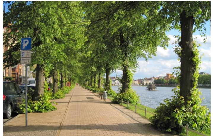
Die sanierte Promenade am Westufer lädt zum Flanieren und Verweilen ein.
