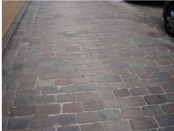
Abbildung 39: Ebenes Pflaster in gebundener Bauweise in der Friedrichstraße
